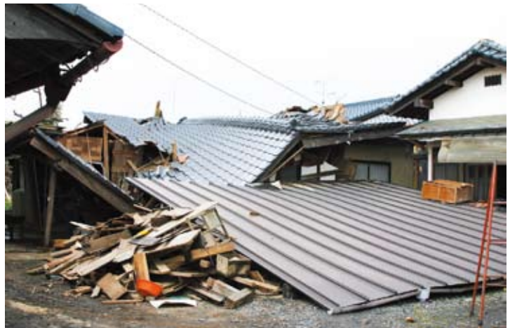
倒壊した家屋
