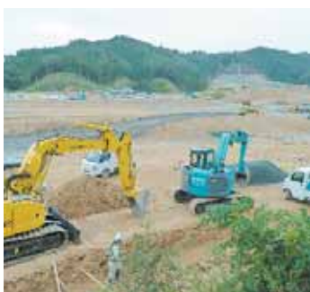
復興に向けて造成工事中(女川町)
