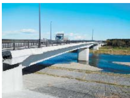
那珂川に架かる全長464mの那珂西大橋
