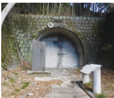
鎌倉坂ロードパーク 勝見沢隧道笠間側杭口跡
